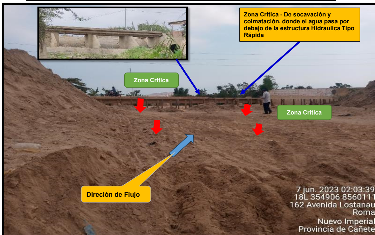
FIGURA N°05: SE MUESTRA EL CAUCE DE LA QUEBRADA POCOTO, DONDE PASA EL AGUA POR DEBAJO DE LA ESTRUCTURA HIDRAULICA TIPO RAPIDA CON REGILLA, CON LA AVENIDAS MAXICAS DE CAUDAL HAN RETIRADOS LAS REGILLAS, POR LA OBSTRUCCION, PRODUCIENDO ASI EROSION Y
