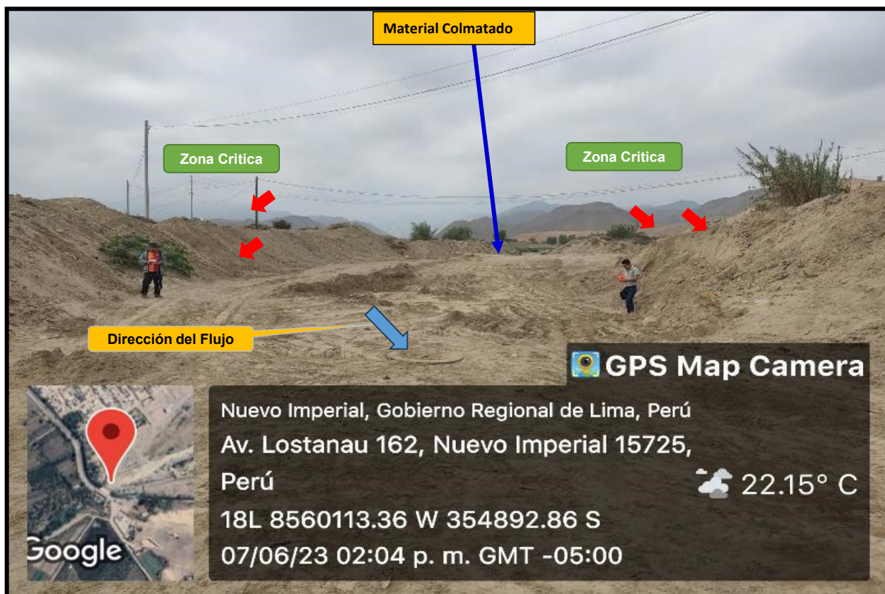
FIGURA N°04: MEDIDA DEL ANCHO DEL FINAL DEL PUNTO CRITICO DE LA QUEBRADA POCOTO DEL SECTOR ROMA, EN ESTA PARTE EL MATERIAL ES SUELTO.
